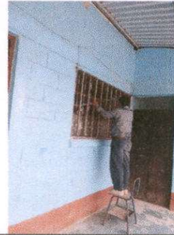
Foto 4: Trabajo en proceso para la sustitución de balcones de metal.
