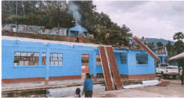
Foto1: trabajo en proceso para la sustitución de lamina.
