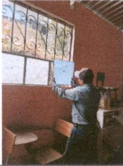
Foto 3: Trabajo en proceso para la sustitución de vidrio
